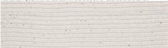
Abb. 54: Kalkputz außen - Besenstrichputz / Oberflächenstruktur fein - gebürstet
